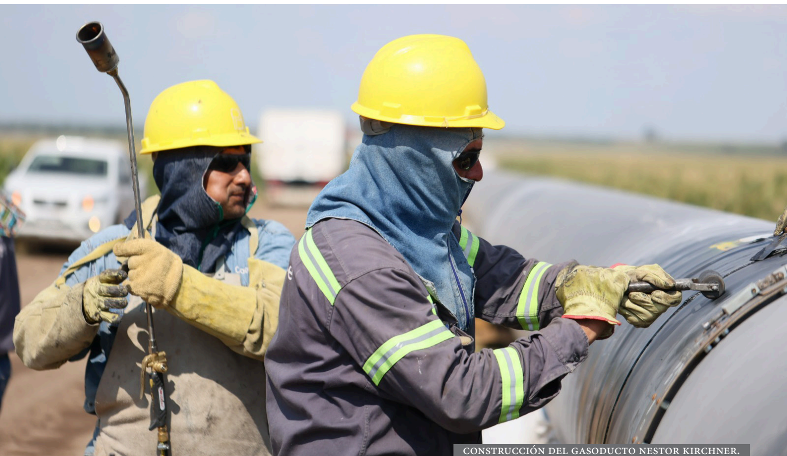
CONSTRUCCIÓN DEL GASODUCTO NESTOR KIRCHNER.
